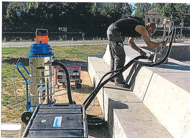
Mit Unterdruckstrahltechnik können verschiedenste Untergründe umweltfreundlich und schnell von Graffiti befreit werden.
